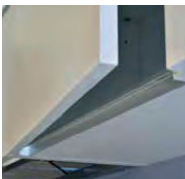
FONDO PENSILE CON PRESA MANIGLIA A SCOMPARSA: Si tratta di una gola in alluminio per apertura pensile senza maniglie
